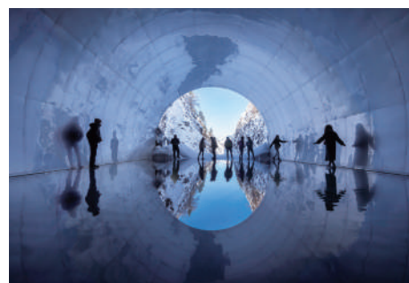
清津峡溪谷トンネル 「Tunnel of Light」 マ・ヤンソン / MAD アーキテクト Photo Nakamura Osamu
