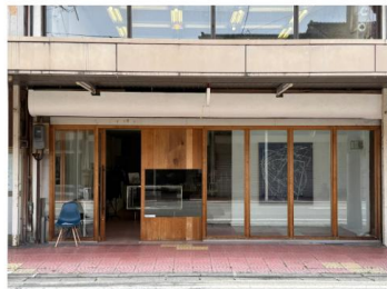
両津商店街の空き店舗をギャラリーに改装したTAACHI. GALAXY SADO ARTやAIRの拠点にもなっている。
